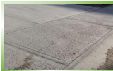
Spalling
